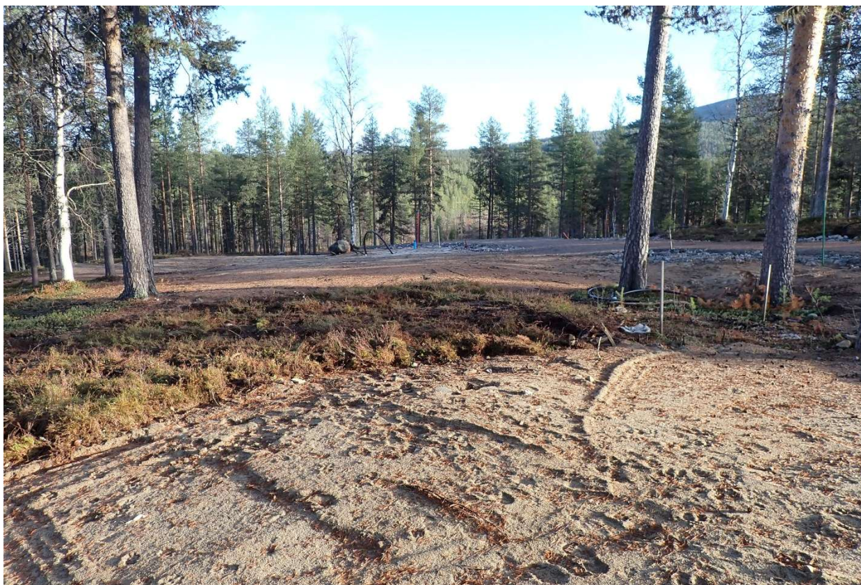
Kuva 8. Kankaan lakialue oli kokonaan kaivettu. Alueella on ollut majoitustoimintaa 1950-luvulta saakka. Viimeisimmät kaivut liittyvät edellisten rakennusten purkuun ja uusien rakennustöiden valmisteluun. Etelästä.
